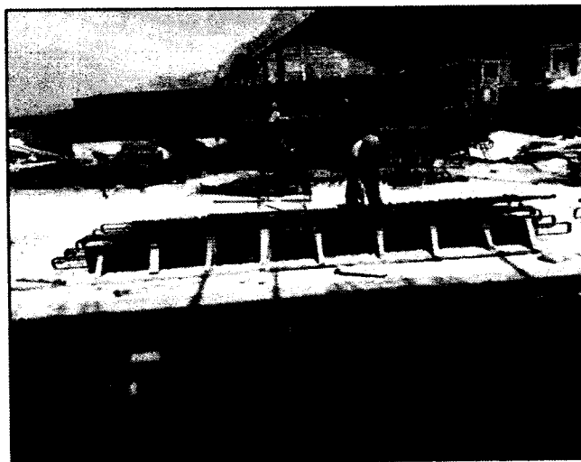
Imagen 2. Encofrado para losas nervadas.
