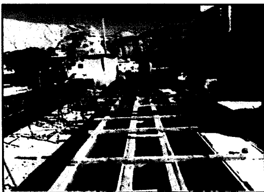
Imagen 3 y 4. Fabricación de pilotes para el cabezo y la plataforma baja.
